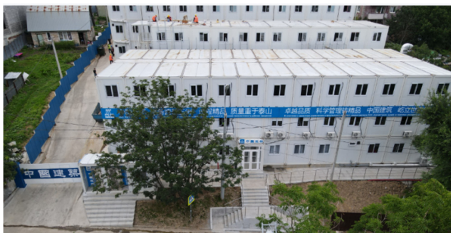
Рисунок 2 – Временные здания построены ООО «КитайСтрой», в г. Владивосток, (объект: "Музейный и театрально-образовательный комплекс в г. Владивосток" ул. Гоголя 9.)
