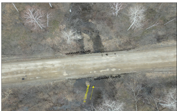
Рис. 3. Вид сверху на мостовой переход через реку Солонцовая
