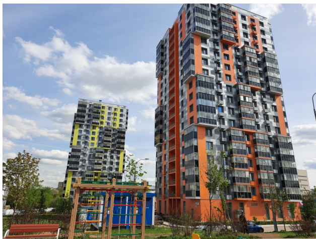
Рис. 4. Дома по реновации. Район Котловка
