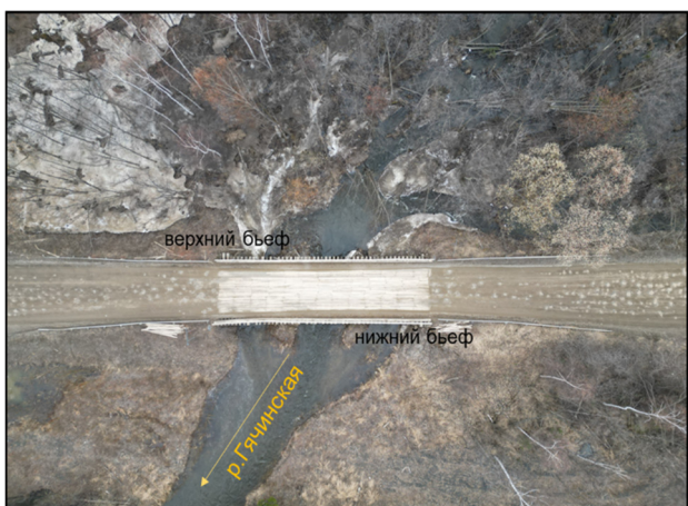
Рис. 2. Вид сверху на мостовой переход через реку Гячинская
